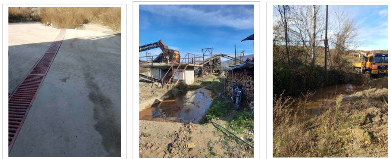
Слика II.4, 5 и 6: Одводни канали, таложници пред влив во Крива река
