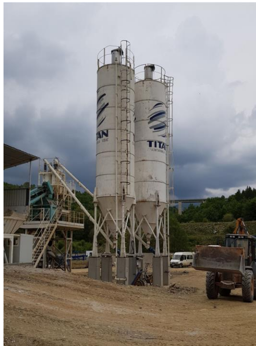
Слика 6. Силоси за складирање на цемент
