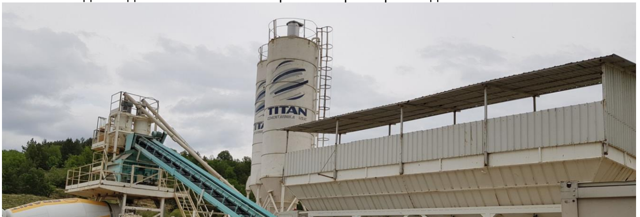
Слика 4. Бетонска база, силоси за цемент и боксови за агрегат
