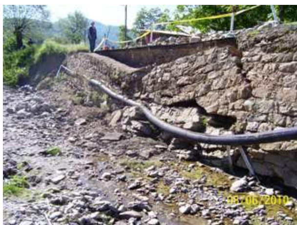
Слика бр. 56 Уништување на потпорен сид – с. Узем и негова санација (2010)
