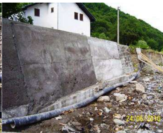
Слика бр. 56 Уништување на потпорен сид – с. Узем и негова санација (2010)
