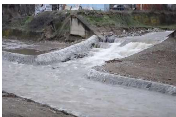
Слика бр. 58 Регулација на порој во урбаната средина
