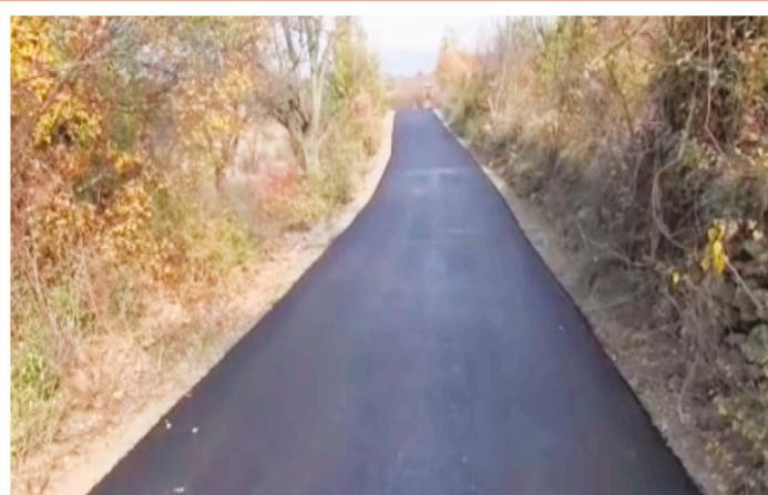
Го реализирајме проектот „**Изградба на општински пристапен пат спој М2–Стамболиска маала-маала Деловодци**“ во селото Конопница во должина од 1.200 метри. Изградбата на патот опфати проширување на трасата на постојниот земјен пат, изработка на постелка, тампонирање и асфалтирање и канализирање на атмосферски води. Проектот беше финансиран од Агенцијата за финансиска поддршка на земјоделството и руралниот развој и од Буџетот на општина Крива Паланка во вредност од околу 5.000.000 денари.
