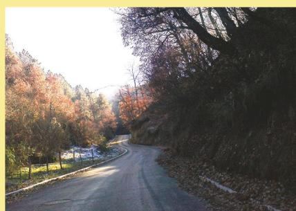
На улицата „**Климент Охридски**“ извршено е проширување на трасата, изработка на постелка, тампонирање, одводнување и асфалтирање на коловозот во вкупна должина од 277 метри и ширина од 5 метри во вредност од 3.400.000 денари.
